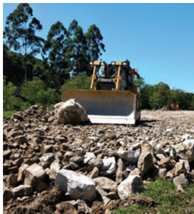
Caminhos de serviço garantem o suporte para tráfego de equipamentos e máquinas pesadas
