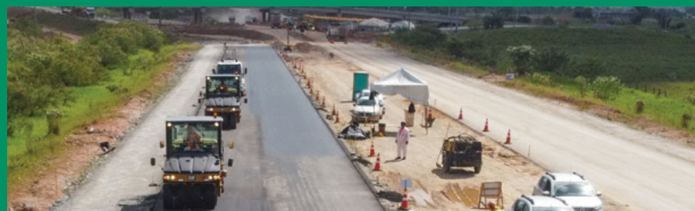
Obras de pavimentação avançam nos trechos norte e intermediário
