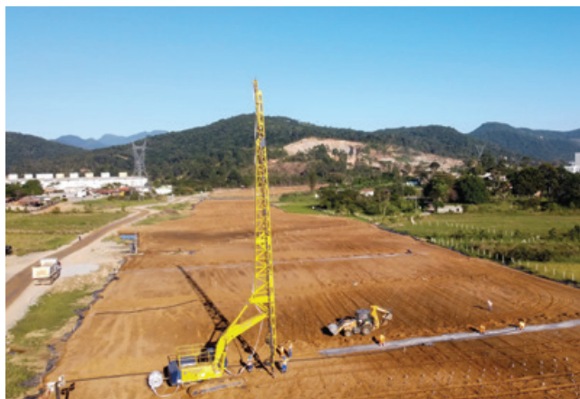
Trabalhos de infraestrutura de terraplanagem em andamento na região de Palhoça-SC
