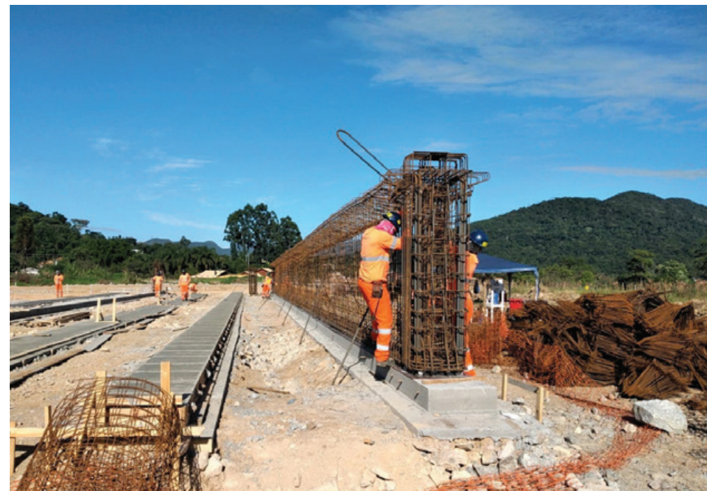
Construção de vigas é uma das primeiras etapas da obra de implantação do trevo
