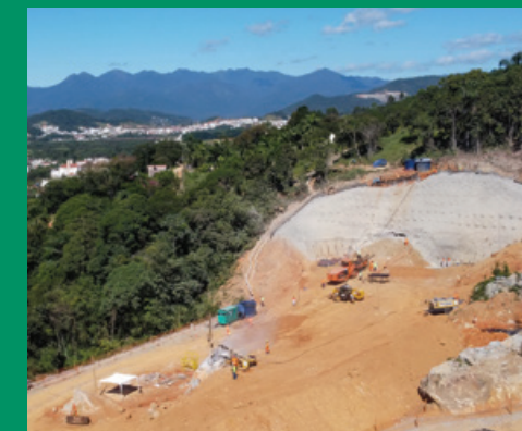
Trabalhos em andamento na construção do emboque do túnel 1 em Palhoça-SC
