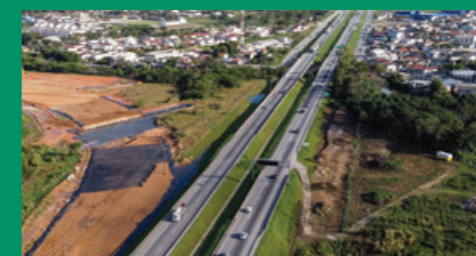
Área do trevo recebe preparação para fundação dos viadutos
