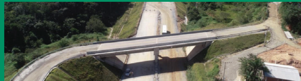
Trânsito local passa sobre o viaduto
