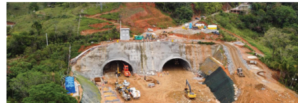
Escavações subterrâneas estão em andamento em todos os túneis
