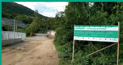
Faixas são colocadas nas vias de acesso
